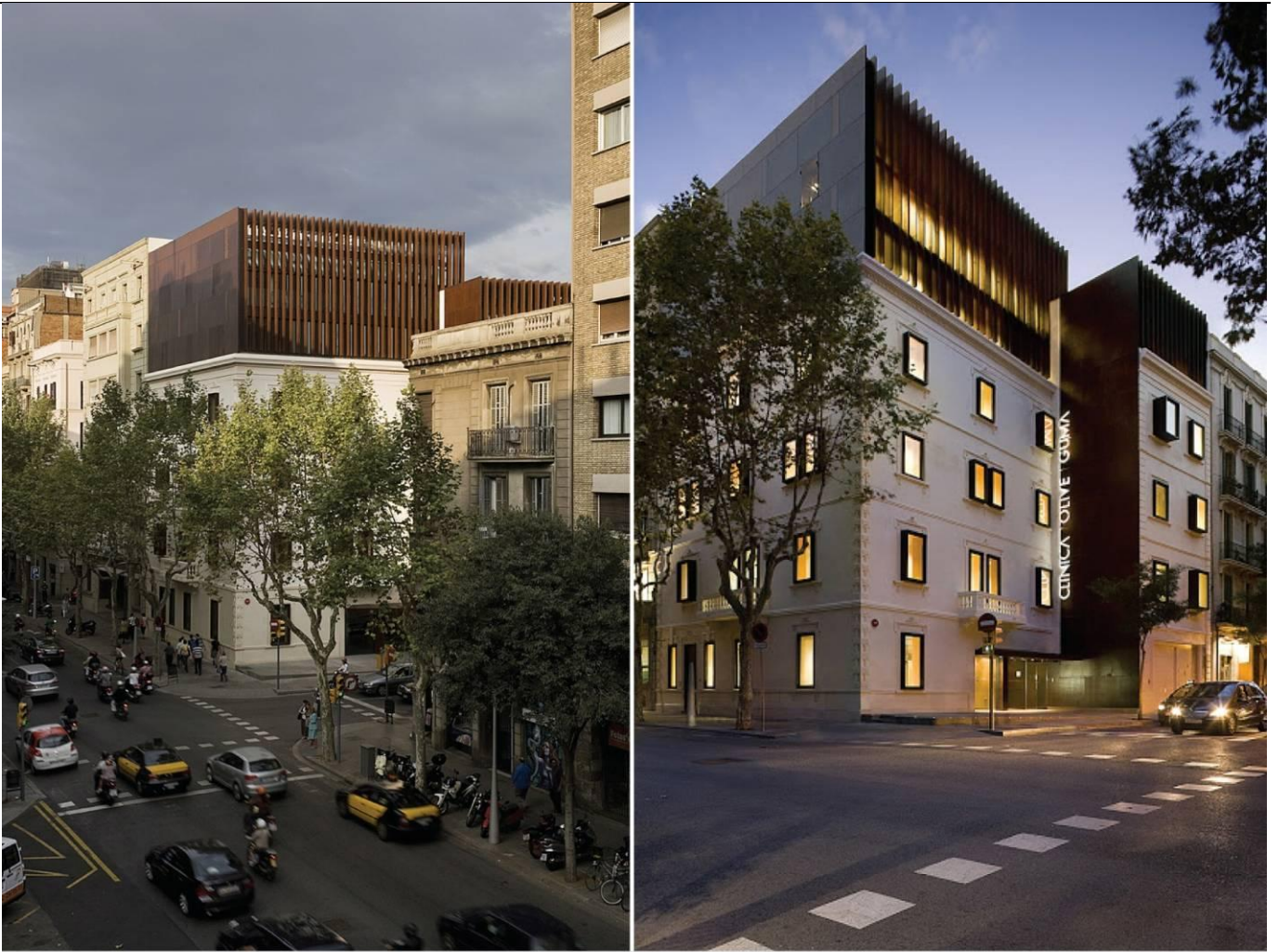
Octavio Mestre + Guim Costa_Reabilitare și extindere Clínica Olivé Gumà_foto: Lluís Casals
