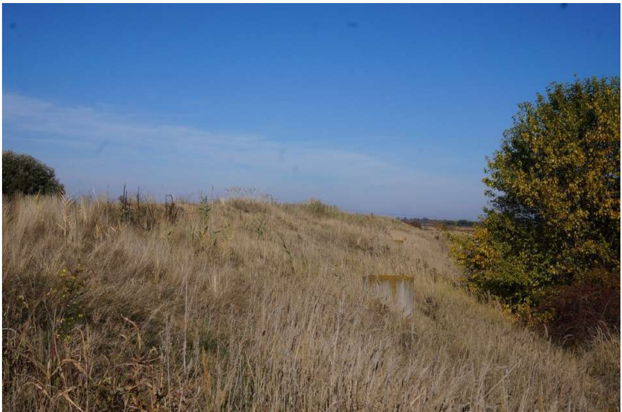
Taluzul estic al compartimentului 3 cu căminele de urmărire a exfiltrațiilor
