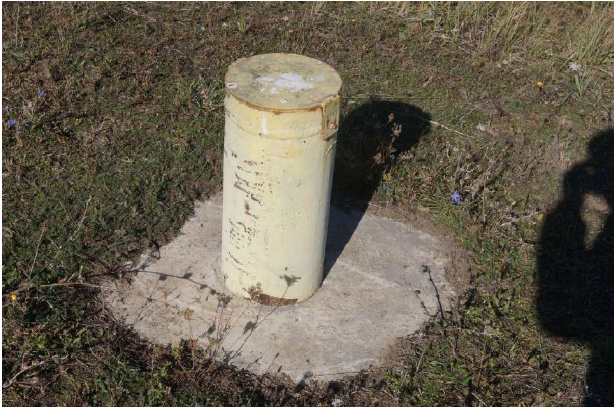
Puț piezometric cu capac pe digul de compartimentare
