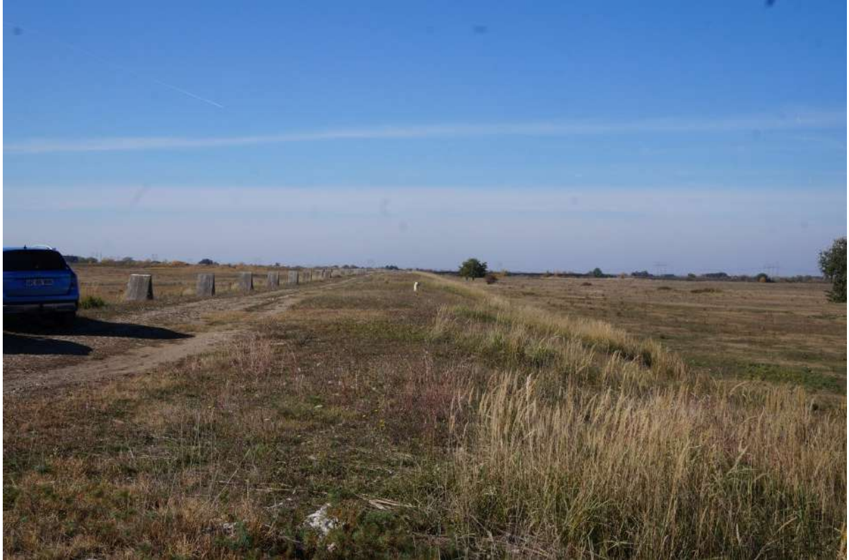
Digul de compartimentare între Compartimentele 2 și 3
