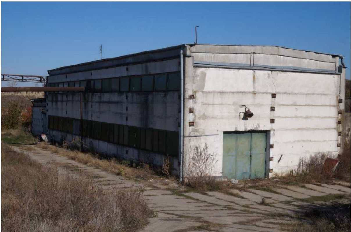
Stația de pompare a apelor de precipitații sau de stropire a vegetației
