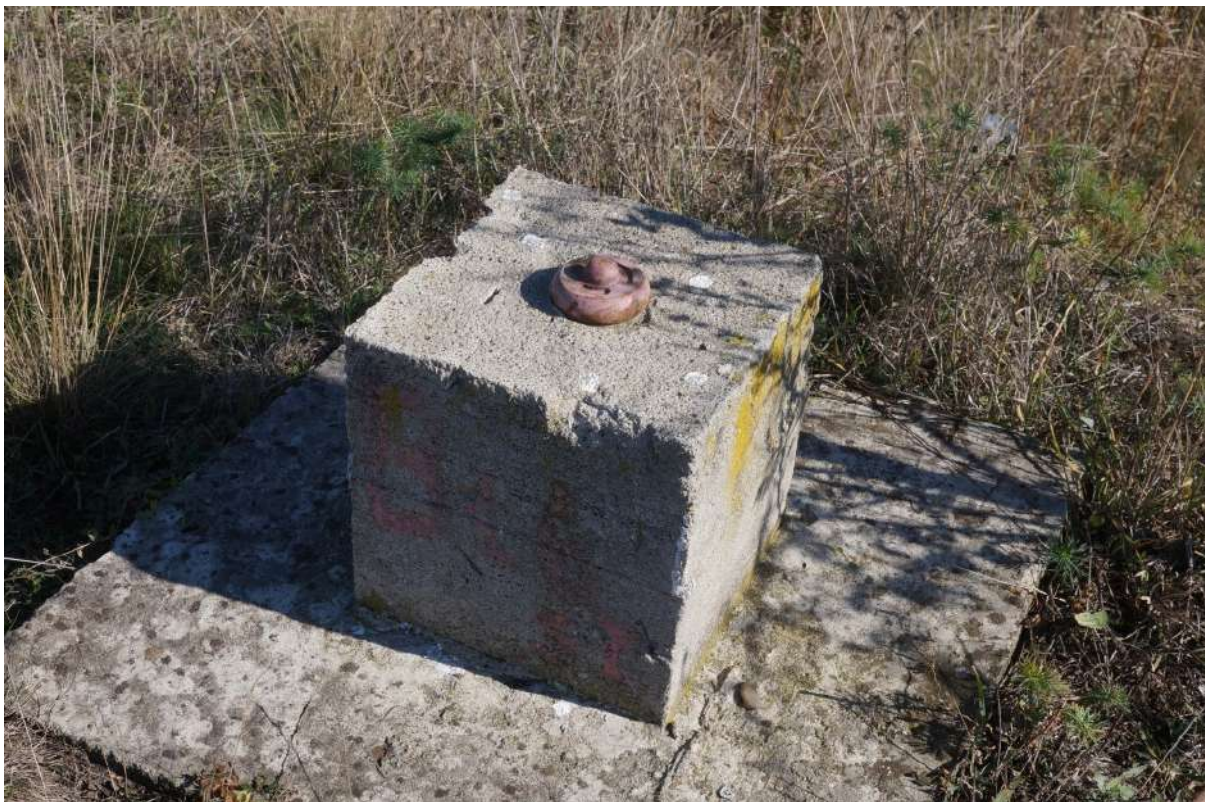
Bornă topografică amplasată pe digul de compartimentare
